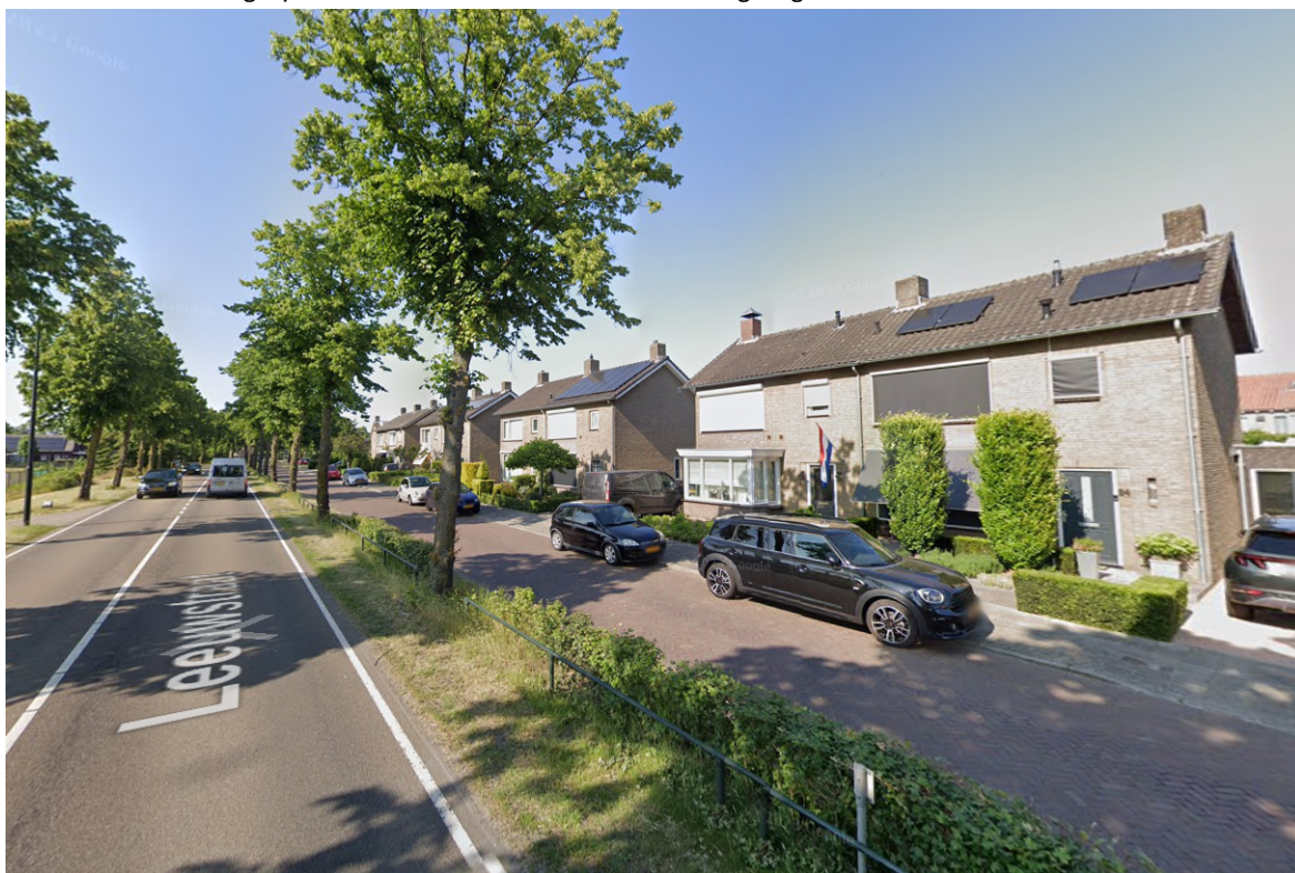
Figuur 12. N605 ter hoogte van Leeuwstraat.
