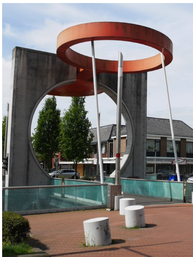
Afbeelding 9 Europabrug, lintbebouwing kanaalzone
