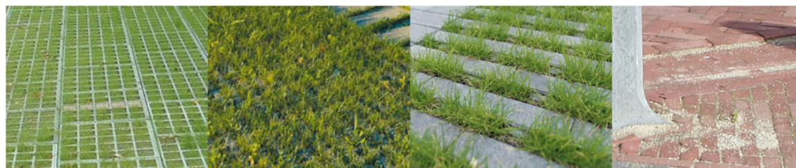
Parkeren - groene open verharding of betonstraatsteen
