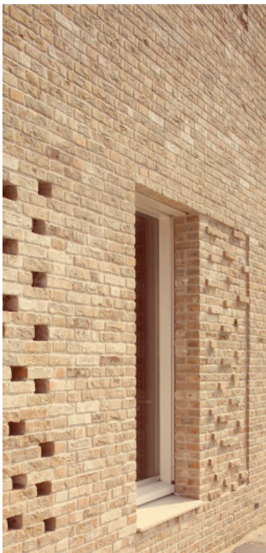
eenvoudig detail door speels rijk metselwerk
