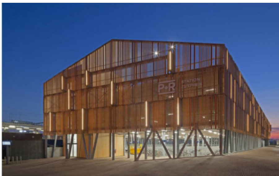
houten gevels op systeembouw met "kapvorm front" en zorgvuldig mee-ontworpen verlichting
