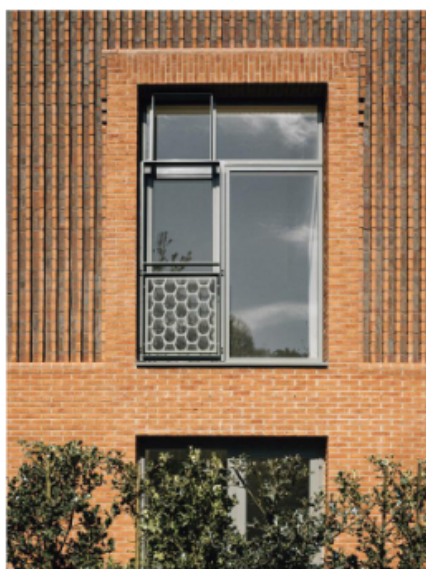
structuren dmv rijk metselwerk
