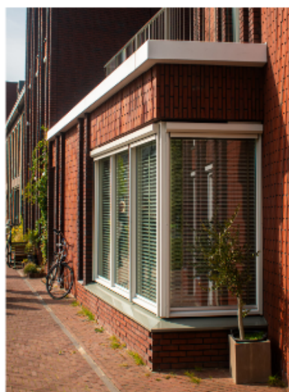
terugkijkraam in erker uitbouw
