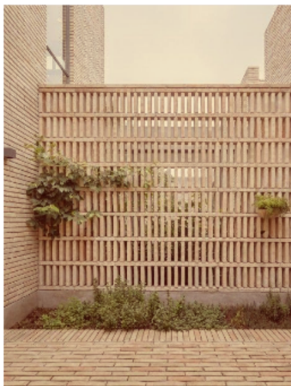
gevelmateriaal doortrekken met Braziliaans metselwerk
