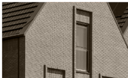
ingemetselde HWA, verholen goot en strakke dakrand
