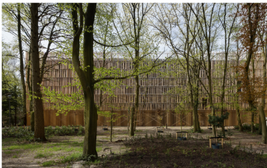
houten gevel op systeembouw passend in de omgeving
