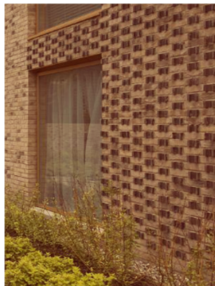
vlakken en kleurverschil door sobere rijk metselwerk
