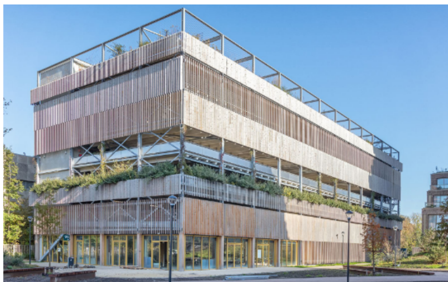
levendige plint in houten gevels met onderverdeling, ruimte voor toekomstige groen (gaas) en opengewerkt dakvorm
