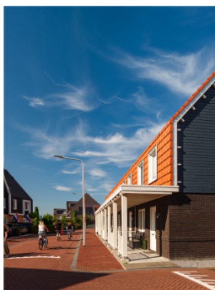
veranda langs langskap
