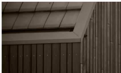
verholen goten iem vlakke pannen
