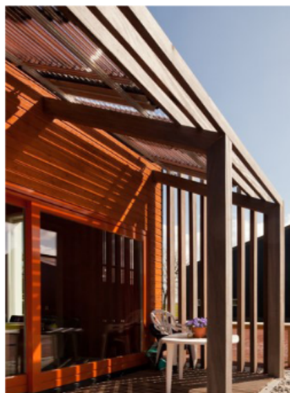
schaduw pergola en veranda met grote gevelopeningen
