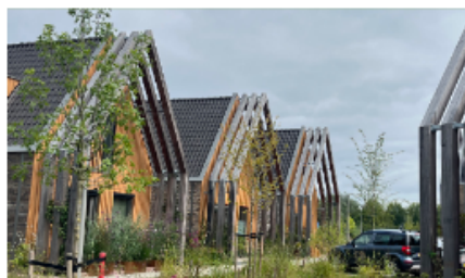
overgang zone onder pergola in kapvorm
