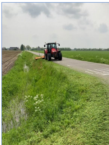
Foto: eerste meter van de berm klepelen. (foto: buitendienst)
