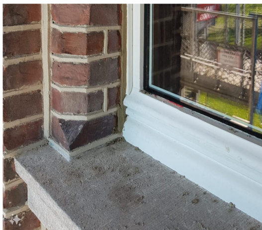
Afb. 24 Voorbeeld: HR++ glas geplaatst in bestaand historisch kozijn met behoud van de profilering.
