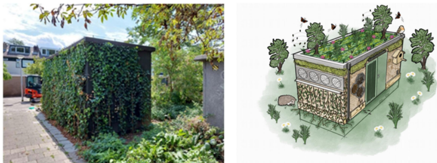
Figuur 15 Voorbeelden van begroeide transformatorhuisjes en huisjes met ecologische meerwaarde Bron: Inpassingskader nutsvoorzieningen, Gemeente Delft & Natuurinclusief bouwen, Naturalis
