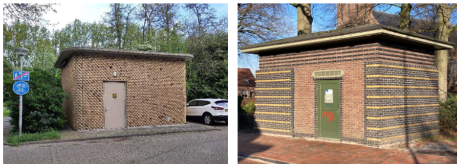
Figuur 14 Transformatorhuisje met bakstenen schil, kansen voor verfraaiing van het straatbeeld Bron: Inpassingskader nutsvoorzieningen, Gemeente Delft & Een huisje in Steenderen, Edy Kwak
