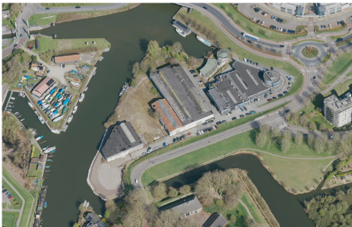
Figuur 2.1.2 Luchtfoto huidige situatie
