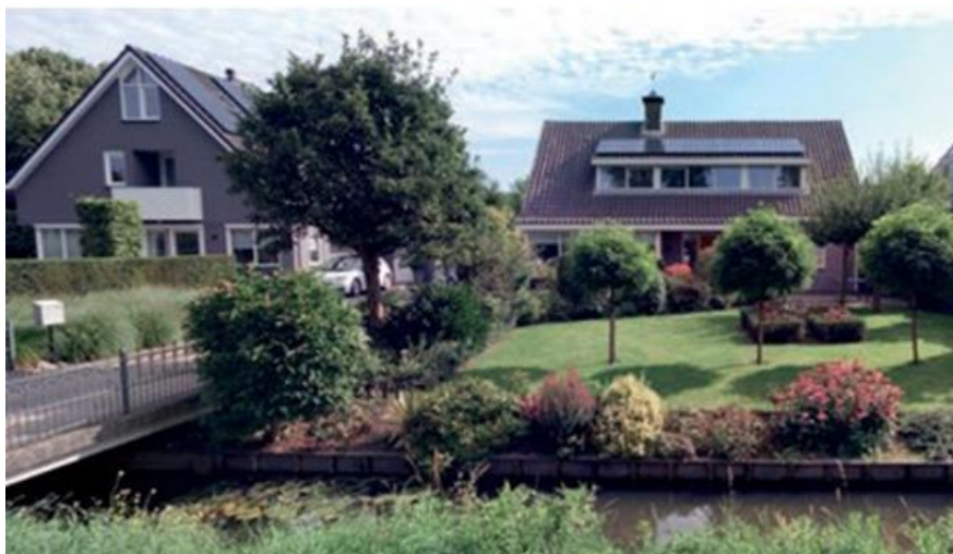
Zonnepanelen afgestemd op dakvlak
