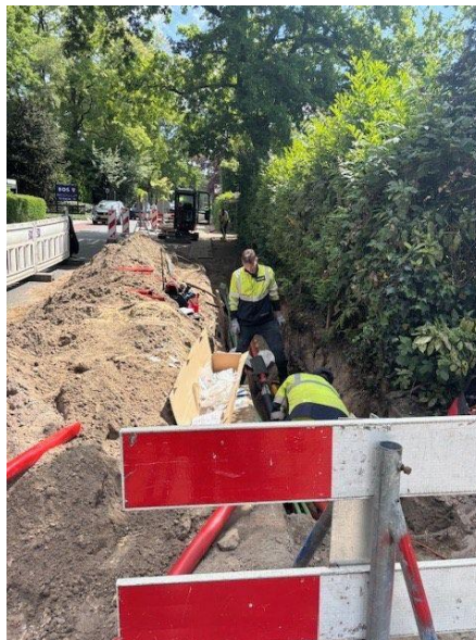
Straten gaan open om nieuwe stroomkabels aan te leggen.
