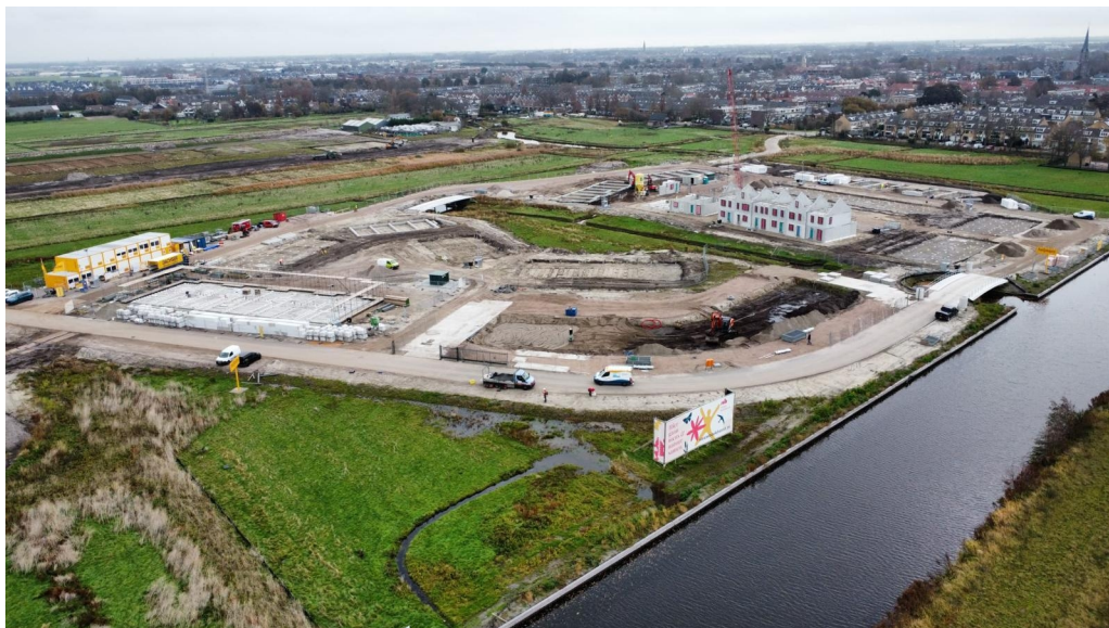
Wijk in aanbouw
