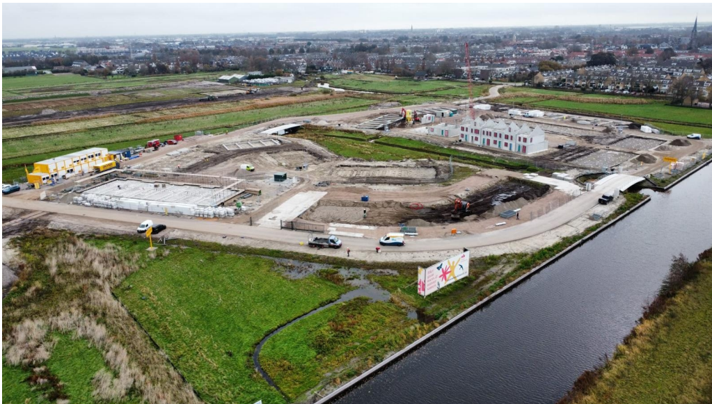
Wijk in aanbouw
