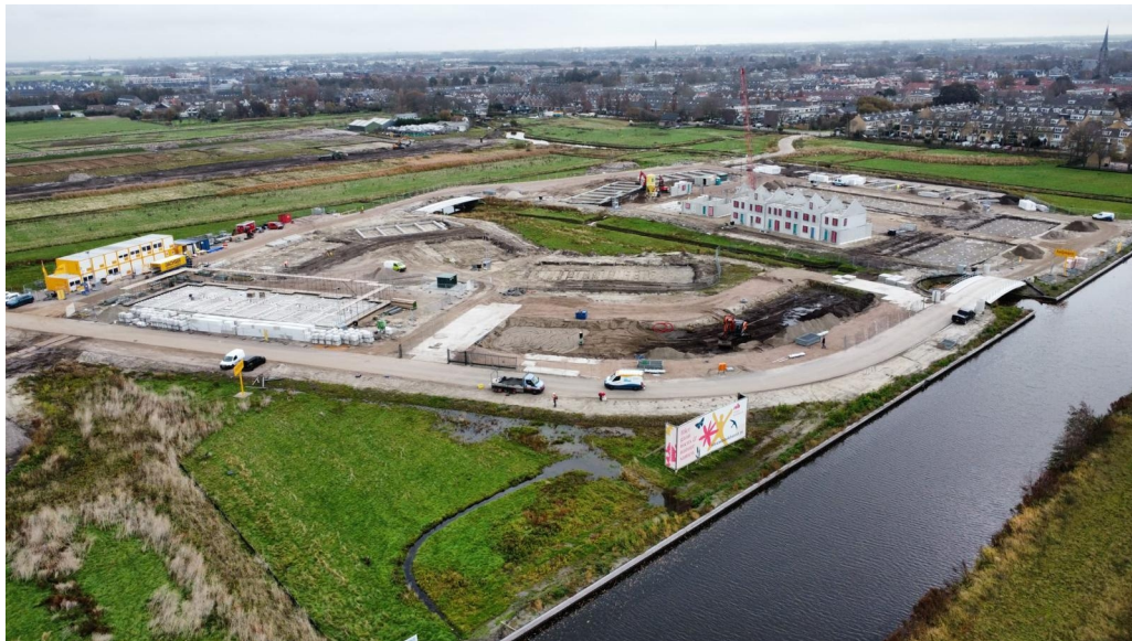
Wijk in aanbouw
