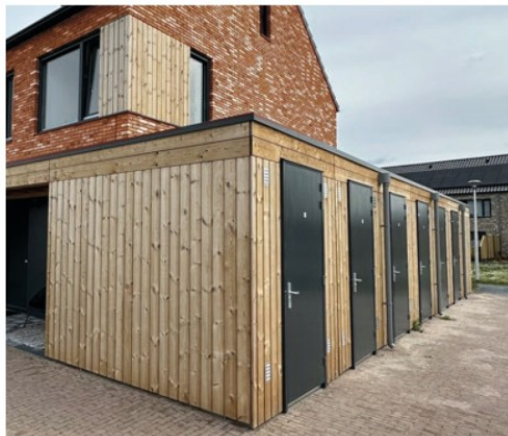
Afb. 2.81 - bergingen aan de zijkant
