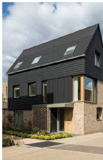
Afb. 3.36 - materialisatie baksteen in combinatie met hout
