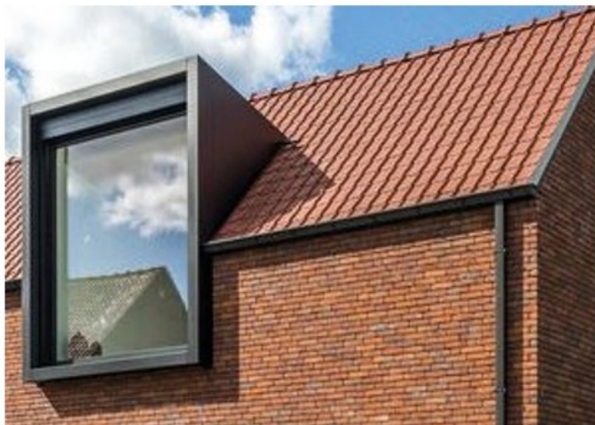
Afb. 2.31 - Referentie sobere dakrand en dakkapel
