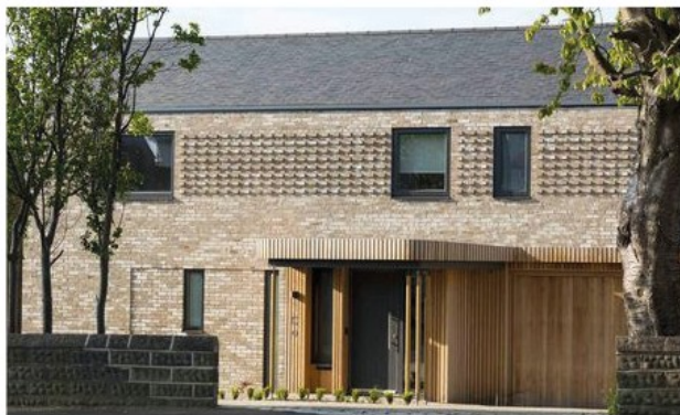
Afb. 2.42 - metselwerk in combinatie met hout
