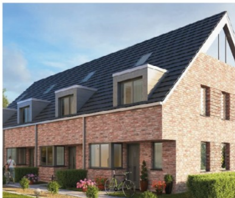
Afb. 3.21 - zadeldak langskap, dakkapelen en gevelverspringing
