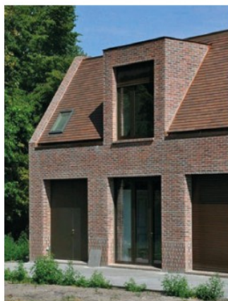
Afb. 3.15 - diepe negge en donkere kozijnen
