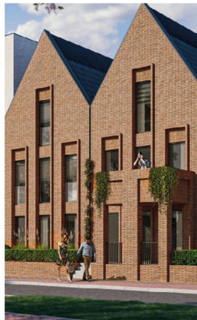
Afb. 3.34 - geleding van de architectuur
