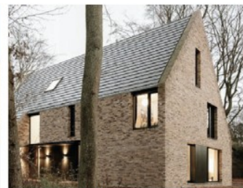
Afb. 2.22 - geleding met grote vlakken en diepe negge
