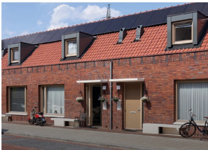
Afb. 3.24 - zadeldak langskap, sociale woningbouw
