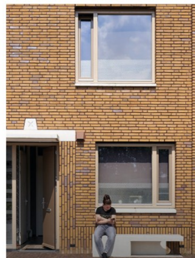
Afb. 3.25 - meeontworpen zitelement in de gevel
