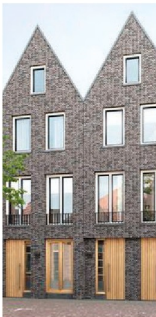
Afb. 3.33 - materialisatie baksteen in combinatie met hout
