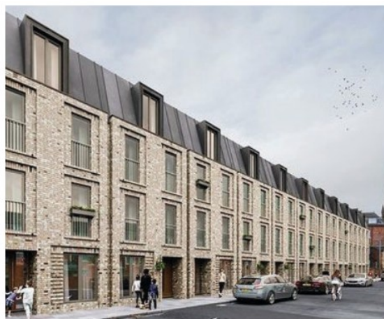
Afb. 3.46 - bovenste etage duidelijk afwijkend materiaal
