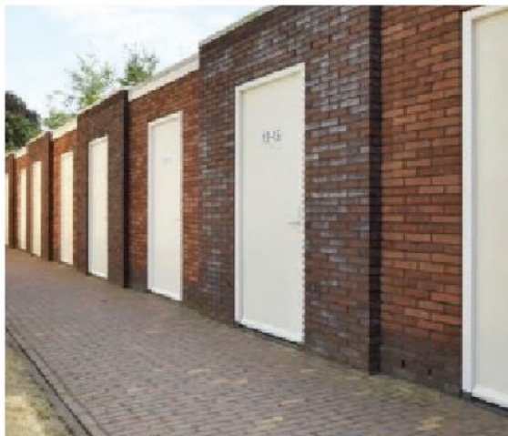
Afb. 2.80 - bergingen aan de achterzijde
