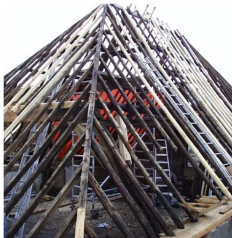
Sporenkap: alleen wat verrot was, is vernieuwd
