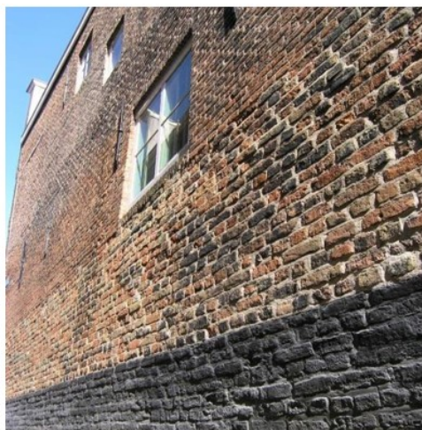
Buitengevel: bouwgeschiedenis zichtbaar
