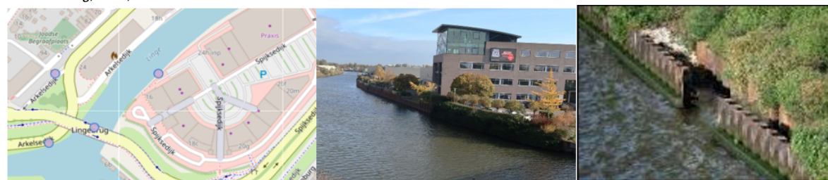
Figuur 22: De Lingebrug en de waterkanten van de Linge. Aan de oostelijke oever zijn alleen stalen damwanden aanwezig. Dieren kunnen hier niet uit het water komen. Hier kunnen uittreedplaatsen voor dieren worden gemaakt (zie de meest rechterfoto; Bron: Waardenburg, 2020).
