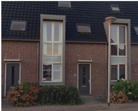
referentiebeeld doorbroken goot deelgebied 2 (bron: Streetsmart)
