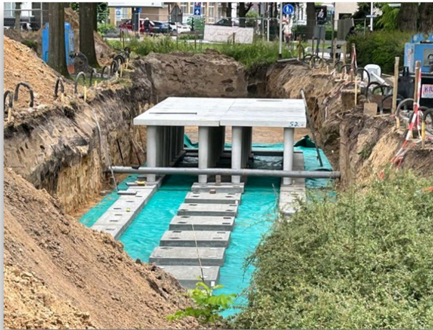
Figuur 2.1 Aanleg ondergrondse waterberging Nassauplein Zundert (foto: Gemeente Zundert)
