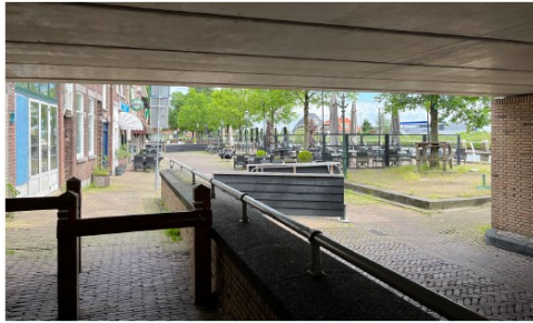
Brugdoorgang: obstakels belemmeren doorgang voetgangers en fietsers.
