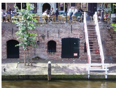
Figuur SEQ Figuur \* ARABIC 1 - blinde muur stratkelder (foto Ruud Voest), kluismuur en werfmuur (foto Wikipedia)
