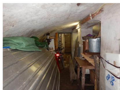
Figuur 3 - voorbeeld dragende constructie, een gordelboog en een dragende middenwand met kolommen
