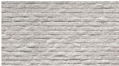
Figuur 5 - voorbeeld esthetisch metselwerkherstel en een afwerking met kaleien
