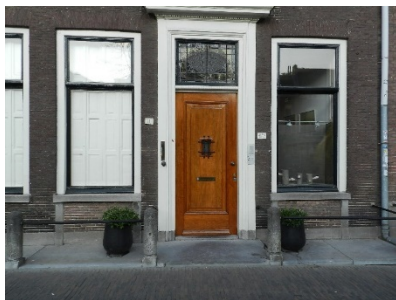
Figuur 2 - monumentale trap en twee voorbeelden van een natuurstenen stoep
