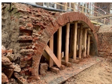
Figuur SEQ Figuur \* ARABIC 7 - een kleine versus een grote kelder en kelder met ondersteuningsconstructie
