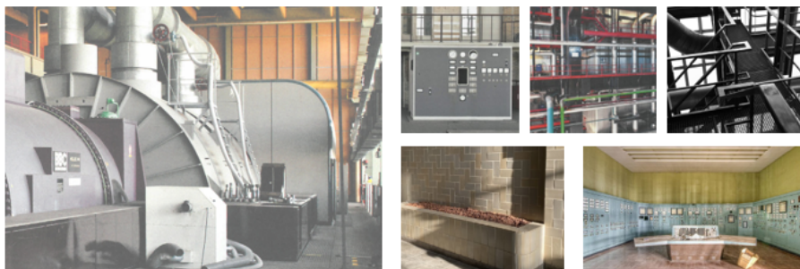
Figuur 2.2.2 | Foto's van de machines en elementen van het interieur van de IJsselcentrale
