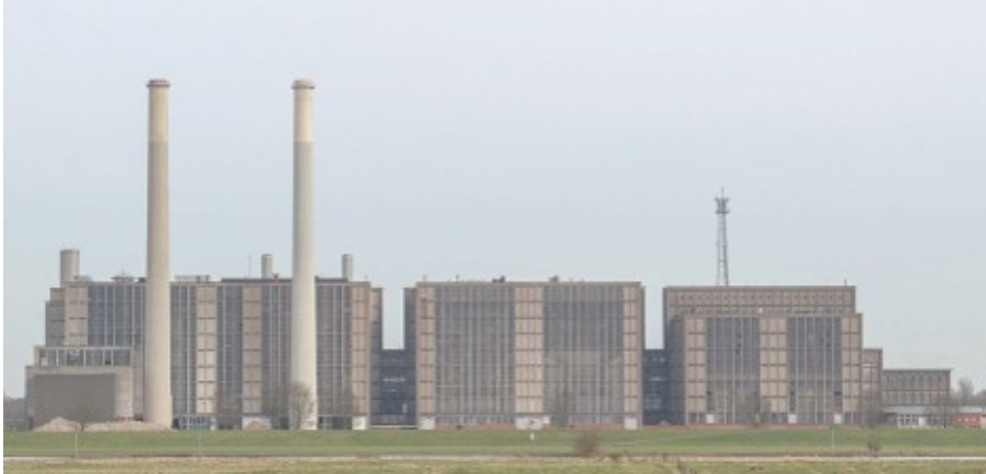
Figuur 2.1.7 | Aanzicht IJsselcentrale vanaf de IJsselszijde
