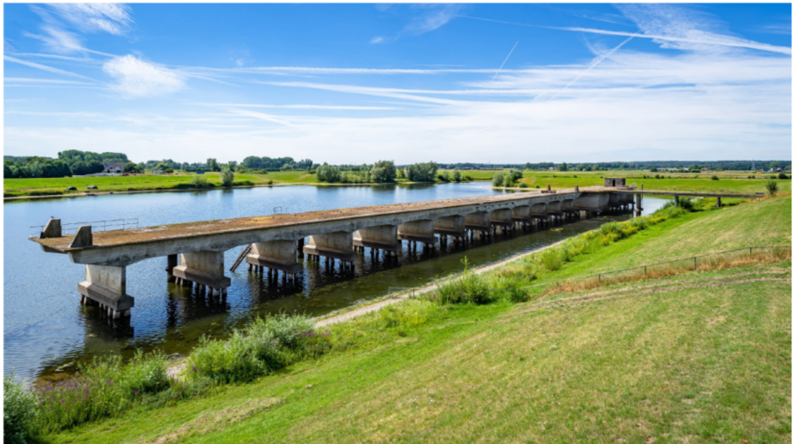
Figuur 2.4.4 | Vogelvluchtbeeld van de zuidelijke steiger
