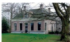
Boerderij Timmerman Dijkhuizen 72 Ruinerwold
