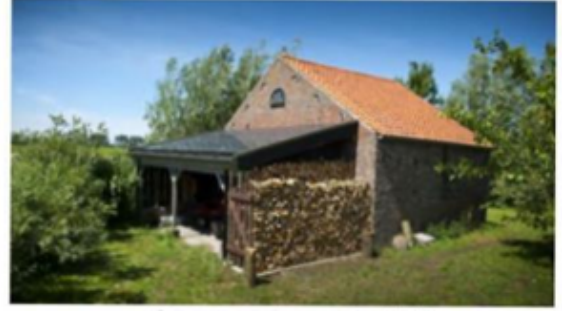
Op een aanbouw (voldak)
