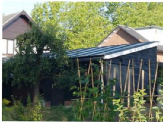
Op bijgebouw syteem met uiterlijk zinken dak
