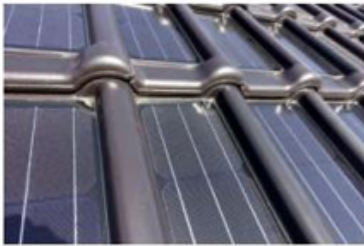
Dakpannen met zonnepanelen
