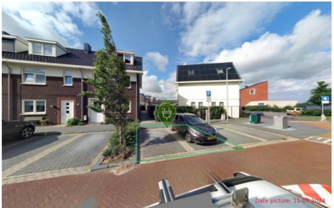
Laadpaal ID 0394-9955: Ingeland 6, 2064KW Spaarndam Coördinaten: 4.679254674725911, 52.409134992231884
