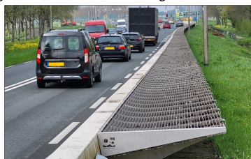
Figuur 14: Diffractor om het geluid af te buigen
