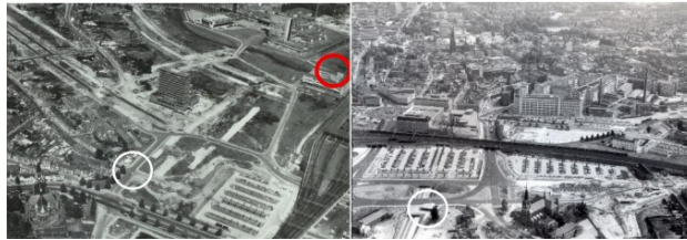
Figuur 2.1 en 2.2: de Fellenoord 1964-65 – witte cirkel oorspronkelijke locatie 'Paddenstoel' – rode cirkel nieuwe locatie 'Paddenstoel' - het voormalige KPN-gebouw juist gerealiseerd, zo ook het voormalige hoofdkantoor Rabobank (gesloopt 2013). En de Fellenoord 1967 vanuit het noorden – witte cirkel oorspronkelijke locatie en juist gerealiseerde 'Paddenstoel'. Nieuwe locatie niet in beeld.
