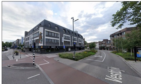
Foto van het Park Plaza hotel vanuit het zuidoosten van het projectgebied.
