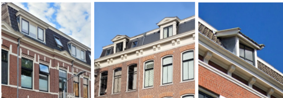
Links een voorbeeld van goed gedetailleerde dakkapellen met een zinken zijkant. Het middelste beeld laat twee goed uitgelijnde dakkapellen zien ten opzichte van de onderliggende vensters. Rechts een dakkapel met slepend dak die karakteristiek is voor sommige bouwensembles in de stad.
