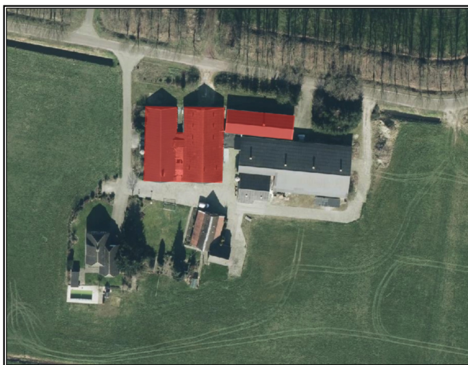
Te slopen bebouwing
