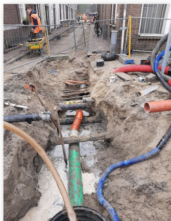
Figuur Rioolreconstructie de Raam Gouda
