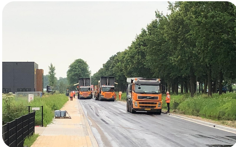
Aanbrengen asfaltverharding Kampen Noord
