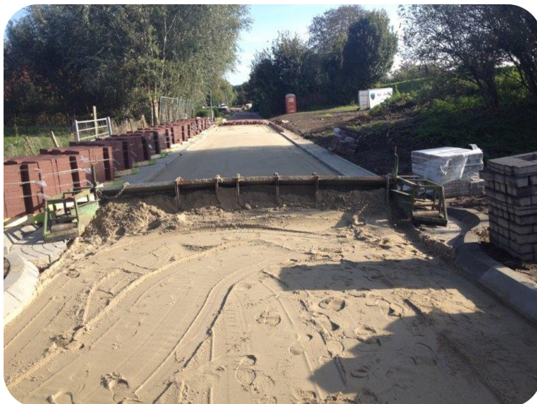
Onderhoudswerkzaamheden aan de Rooijensestraat in Hoenzadriel
