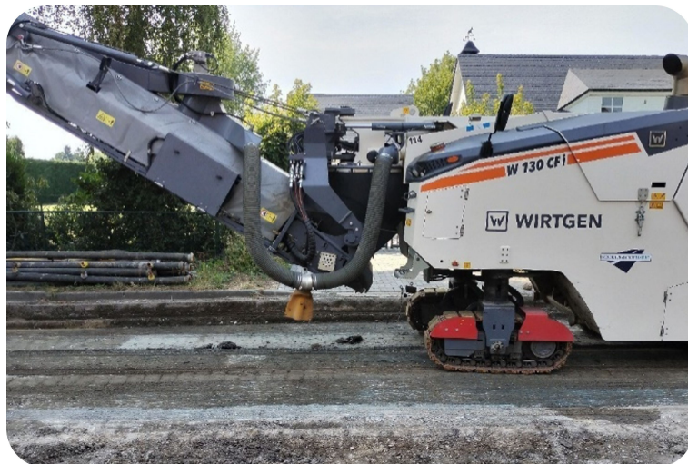
Frezen van de bestaande verharding in de Paterstraat.
