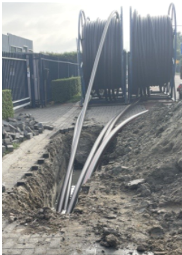
Boring van mantelbuizen ten behoeve van aanleg 20 KV netwerk Liander, Baronieweg in Hedel
