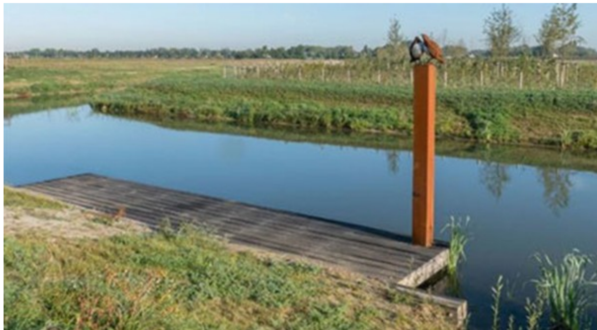
Voorbeeld van een eenvoudige steiger om over te stappen.
