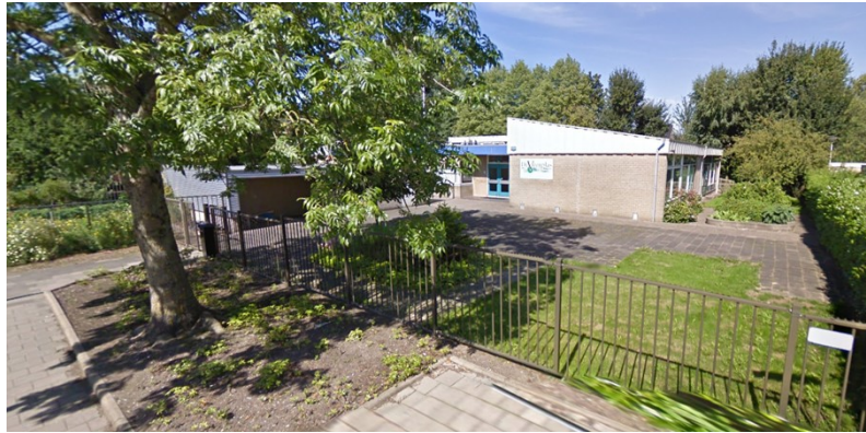
Afbeelding 2.4: Bestaande situatie basisschool de Veevogel (vml. Wegwijzer) vanaf de Ambroziolaan.
