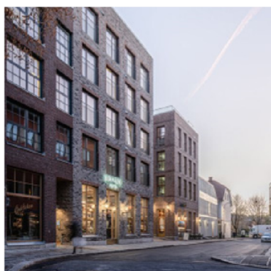
Referentie Herculesstraat, Nygaard Square Renovation, Mad arkitekter, Beeld: Kyrre Sund
