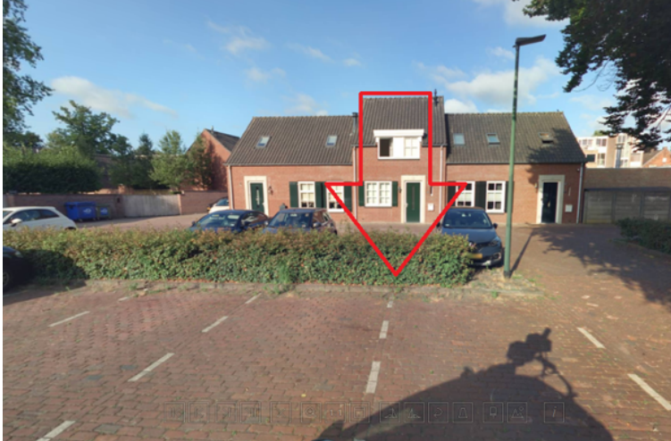
Locatie: Tuinweg 2A Oisterwijk.
