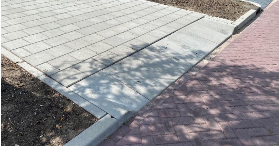
Figuur 8 Inritconstructie door groenvak. Locatie: Balkweiterhoek Zwaagdijk-West
