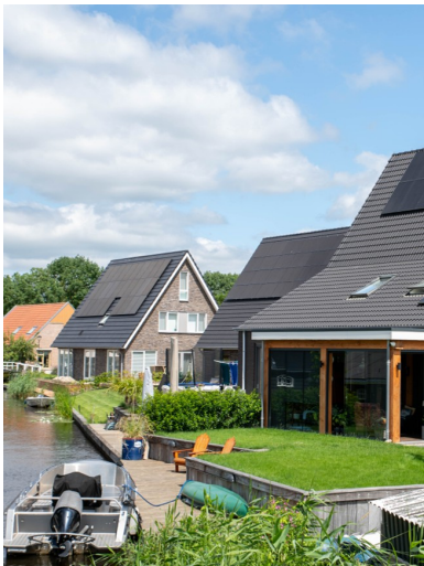
Nieuwbouw Rietveld in Belt-Schutsloot. [Foto: gemeente Steenwijkerland]
