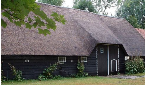
schuur - Zeeland zwarte houten gevels met witte accenten, dakrand verheven boven mendeur
