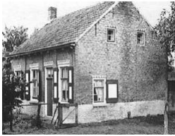
boerderij - Kloosterzande eenvoudig volume, hellend dak
