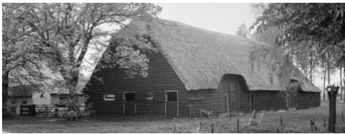
schuur - Westdorpe lage gevels, rieten dak
