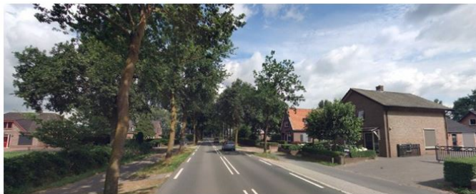
woningen aan de Lunterseweg
