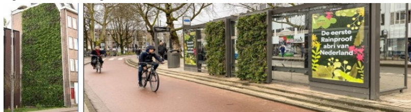
Figuur 19: Voorbeeld groene schermen op bestaande bouwwerken.
