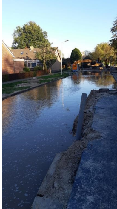
Figuur 4-2 werkzaamheden rioolbaan Rengerstraat Sint Nicolaasga
