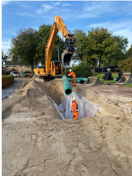
Figuur 1-1 Rioolvervanging en aanleg infiltratieriool in Sint Nicolaasga
