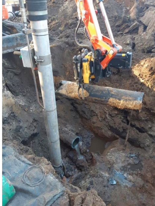
Figuur 6-2 Reparatie van een persleiding in Lemmer
