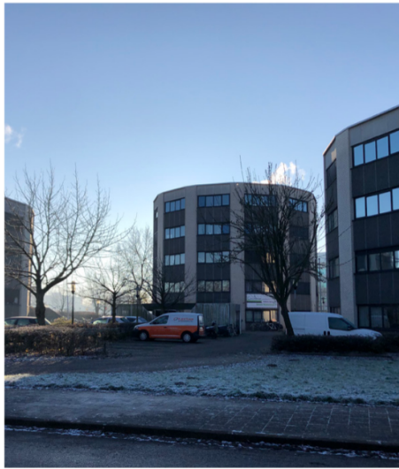
Tijdelijk wonen in bestaande kantoorpanden
