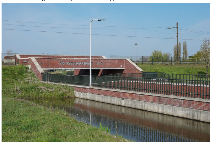
Figuur 7 Project Coenecoop, Prinses Maximatunnel
