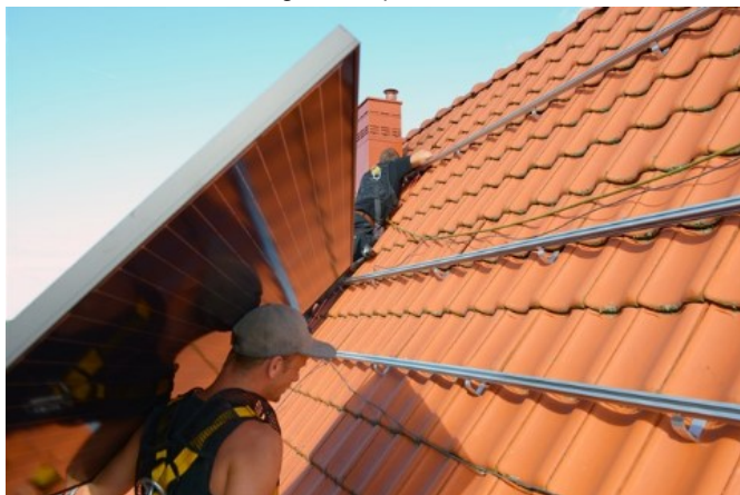
Aanbrengen zonnepanelen Westzaan
