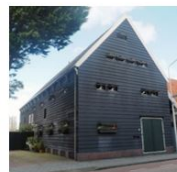
Houtbouw woning aan de Zaan
