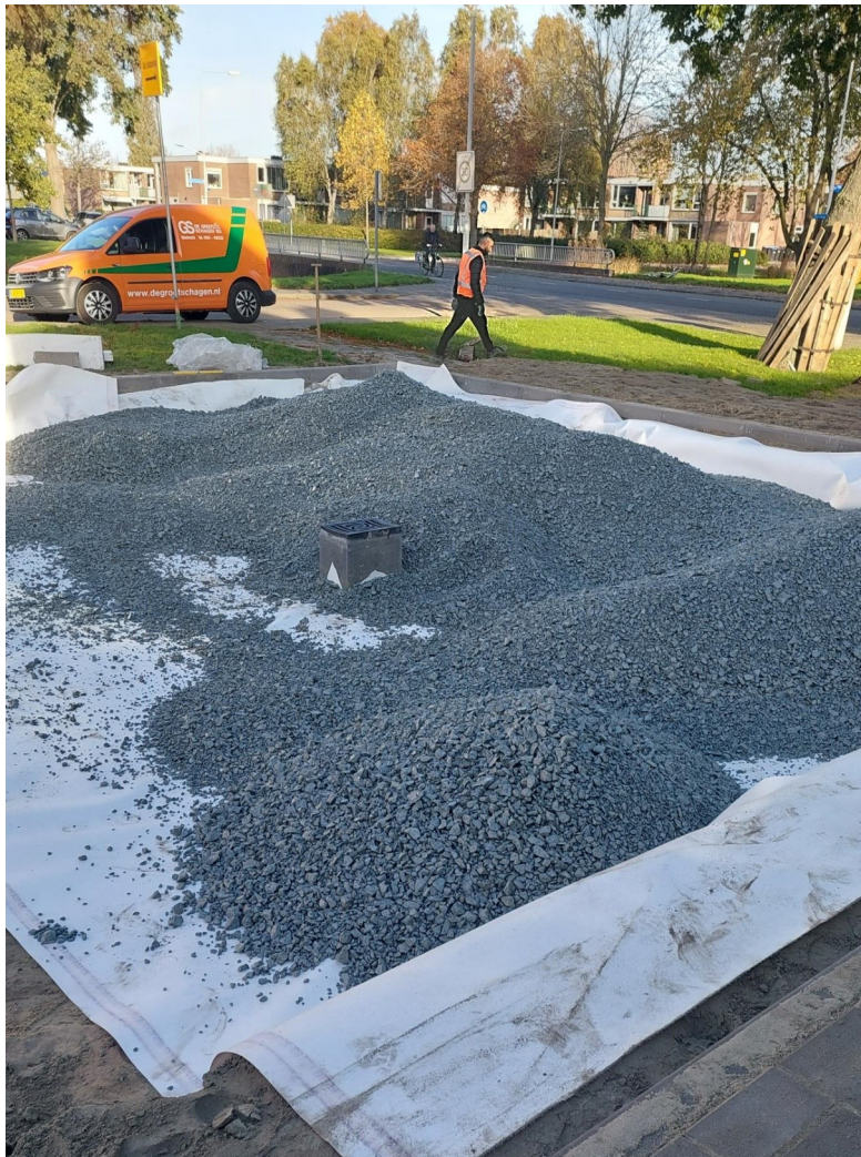
Aanleg waterbergende wegfundering Da Costastraat
