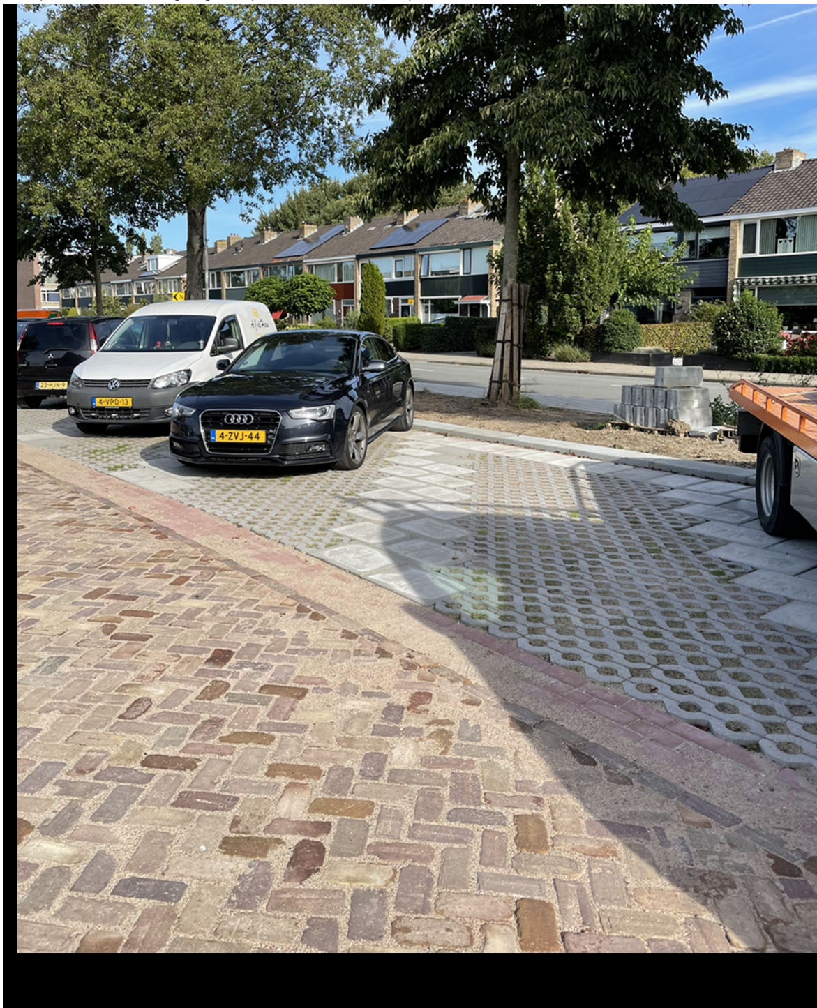
Waterpasserende verharding en groene parkeervakken Van Lennepstraat
