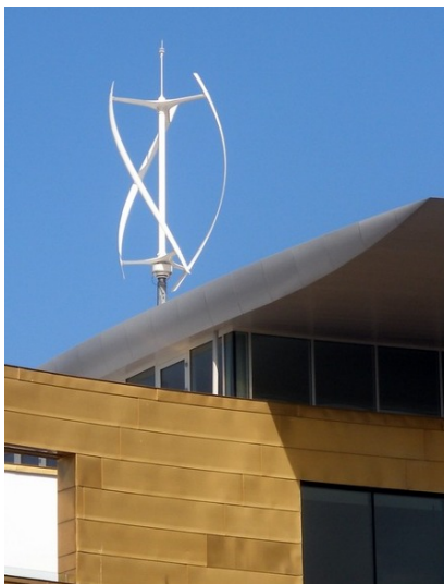
Figuur 59: Windwokkels zijn een duurzame mogelijkheid voor op plekken waar de stroom direct gebruikt kan worden. Denk hierbij aan bedrijvenpanden. De wokkel is duurzaam en maakt geen geluid. Met de juiste installatie is er ook geen last van slagschaduw.
