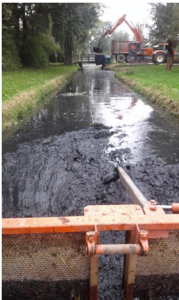
Figuur 20 Baggeren met boot en afvoeren bagger
