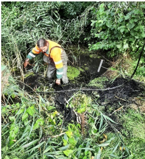
Figuur 23 Doorspuiten waterinlaat door eigen buitendienst
