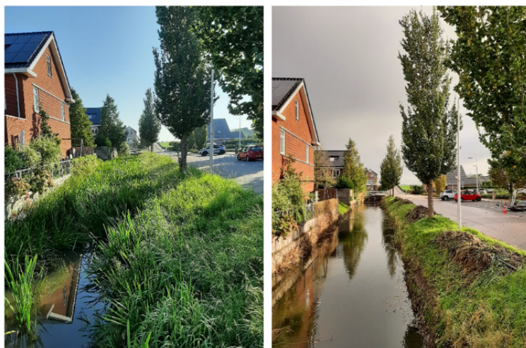
Figuur 10 Watergang voor en na schonen van waterplanten
