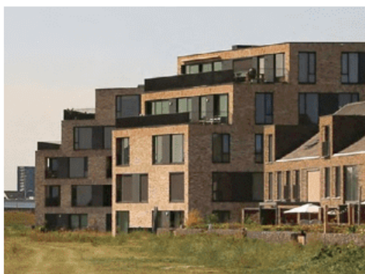
Tuindorpmilieu: benutten van het zicht over de uiterwaarden
