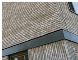
Afwijkend materiaal / metselverband begane grondverdieping
