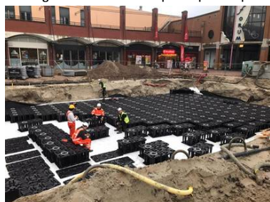
Aanleg stormharvester op Koopmansplein
